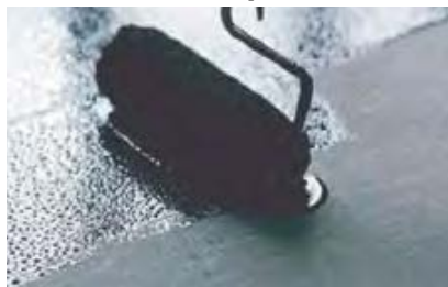
Рисунок 12 – Нанесение праймера на основание.
