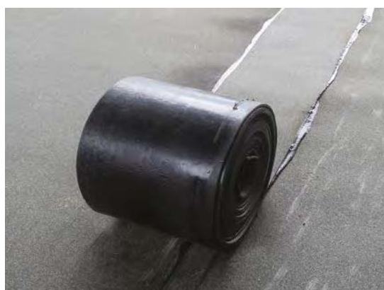
Рисунок 10 – Наплавление Бандажной ленты ICOPAL® .
